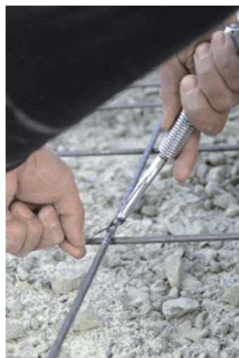
⑥ 回転させているうちにお互いの鉄筋が絞り寄る。
